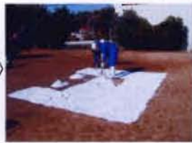
②敷き均し
